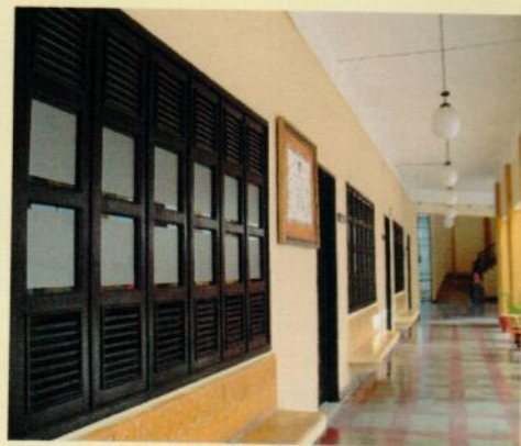
·Ventanas restauradas de las aulas de la Escuela de Normal Primaria del IC.
